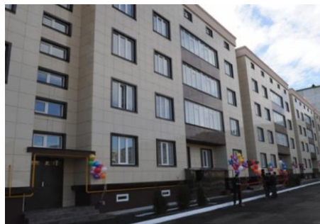
Республика Дагестан, г. Каспийск, ул. Ленина, 3в. Солнечные коллекторы, тепловые насосы. Доля энергии, выработанной альтернативными источниками, – 80% зима / 150% лето
