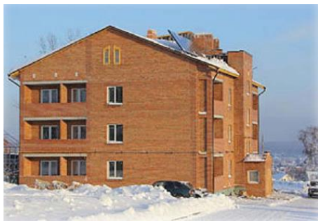
Новосибирская область, пос. Маслянино, ул. 60 лет Октября, 28 В. 657 м 2 , 3 этажа, 18 квартир. Тепловой насос Logatherm WPS-33, солнечный коллектор Logasol SKN 3.0-s верт. V3. Доля энергии, выработанной альтернативными источниками, – 45%.
