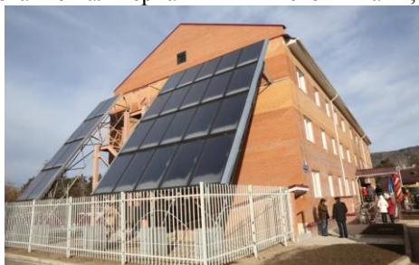
Красноярский край, г. Дивногорск, ул. Бочкина. 24-квартирный жилой дом, 3 этажа, 1425 кв.м. Солнечные коллекторы, тепловые насосы (воздух-вода), рекуператор. Доля энергии, выработанной альтернативными источниками, – 16%.
