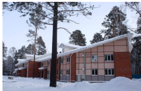
Иркутская область, г. Ангарск, квартал 251, 2 этажа, 24 квартиры. Площадь 1097 м 2 . Солнечные вакуумные водонагреватели ГВС с коллекторами, тепловой насос с использованием низкопотенциальной энергии подземных вод. Доля энергии, выработанной альтернативными источниками, – 30%.
