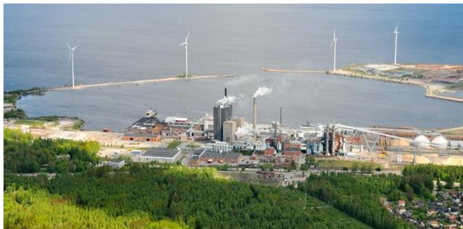
Ветропарк вблизи целлюлозного завода компании Stora Enso в городе Skutskär (Швеция)
